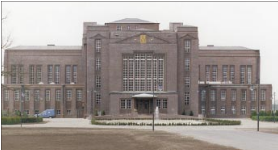
Im denkmalgeschützten Muthesiusgebäude befindet sich unter anderem die Leitzentrale.
