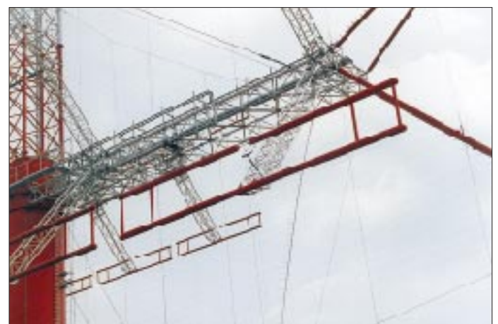
Nahaufnahme eines 15 m breiten Dipols für den unteren Frequenzbereich. Die Drahtseile für die Einspeisung laufen parallel zum Befestigungselement.
