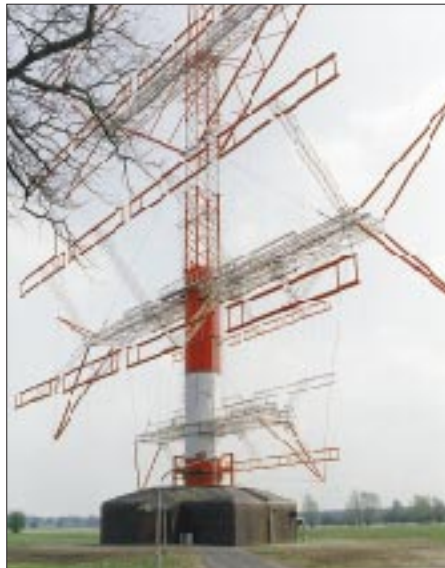
Nahaufnahme einer Drehstandantenne. Der mit Kupferblech verkleidete Sockel bietet Platz für Sender, Kunstantenne und Werkstatt/Ersatzteillager.
